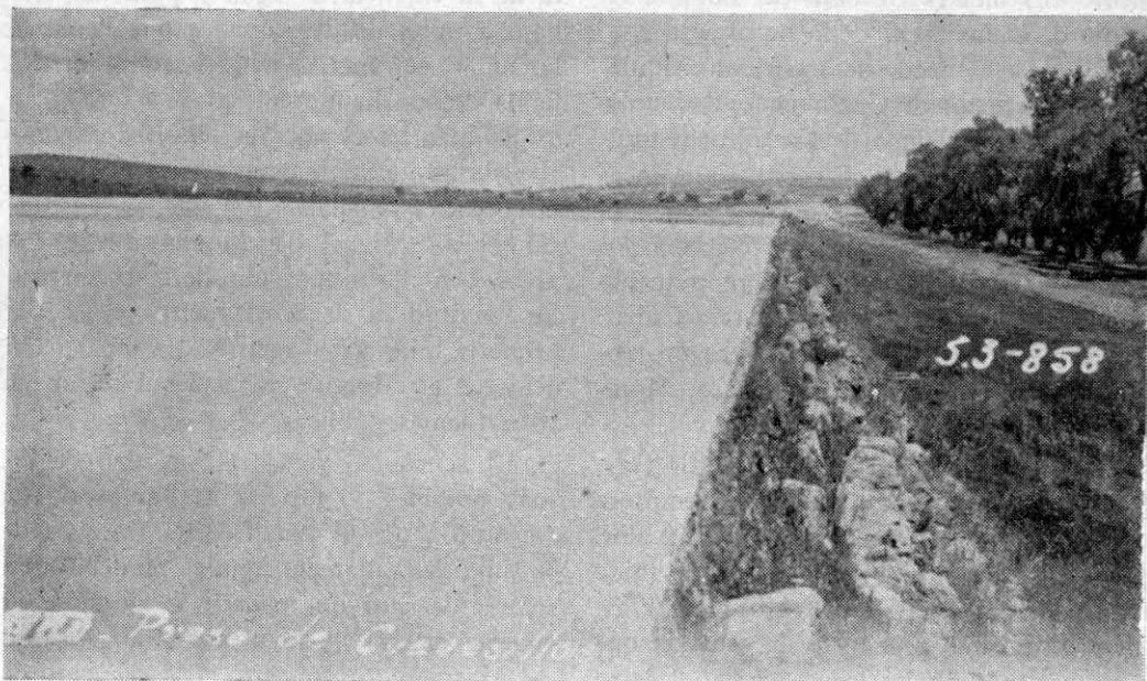
Presa de Cuevecillas en el río Cuautitlán, Hgo.
