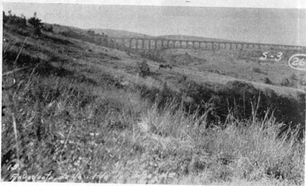
Acueducto de la Hacienda de Xalpa, en el Estado de Hidalgo.
