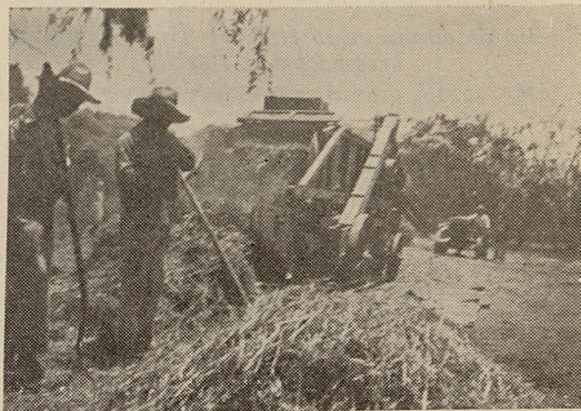
Trilladora Matamoras, ambulante, motor (Tractor Fordson) alimentado con gasoil, en las cercanías de Sta. Clara. Valle de Tehuacán, Pue. Cobran $ 10.00 ton. de trilla. Trilla trigo, cebada, alpiste y avena.
