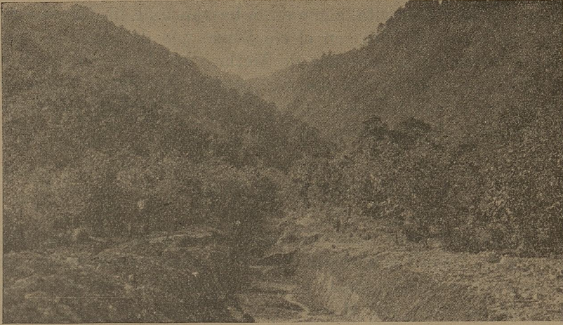
Fot. 13. Entrada de la barranca de "La Bolsa". Km. 263 de la vía del F. C. Mexicano. En primer término, canal de conducción desahogado y ampliado por aquella empresa ferrocarrilera, en diciembre de 1936.
