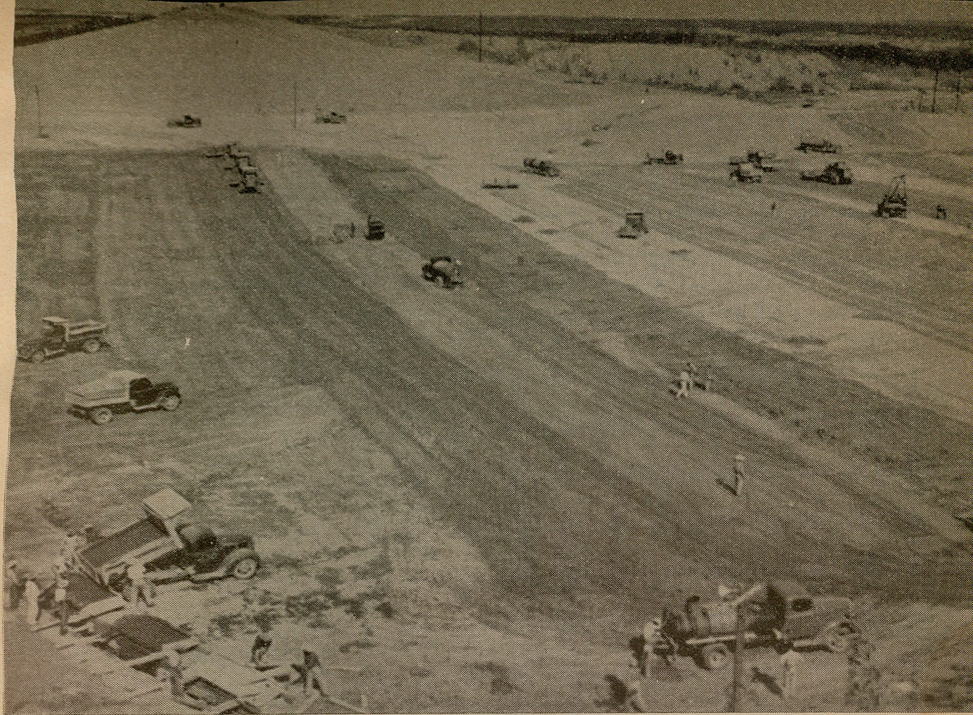
Presa de "El Azúcar". Terracerfías de la cortina de la presa.
