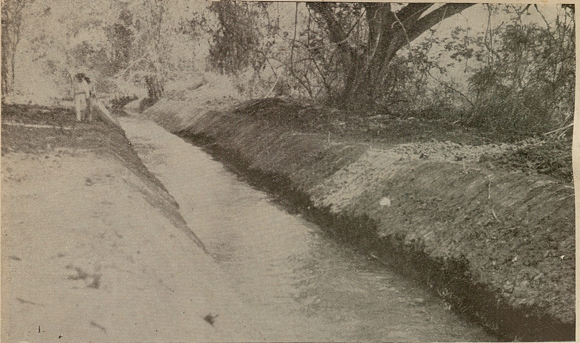
D. R. de Tierra Caliente. Vista de la modificación que se le hizo al río San Antonio y que forma el primer tramo del dren principal, desembocando en el Río Mesiaca.
