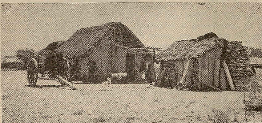
Jacales en el Vaso de El Azúcar, que serán reemplazados por casas de mejores condiciones.
