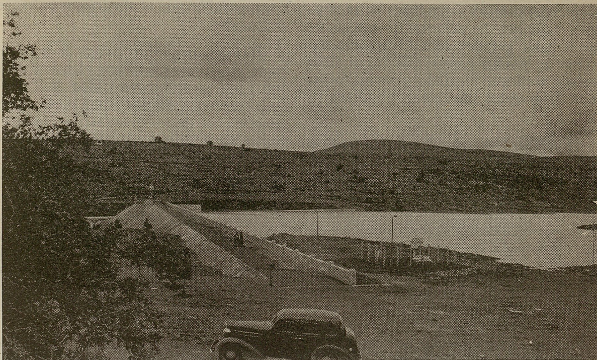
Foto N° 3.—Vista panorámica de la presa de La Esperanza, desde la margen izquierda del arroyo. Nótese el embalse cubriendo la cresta vertedora en el extremo derecho de la cortina.
