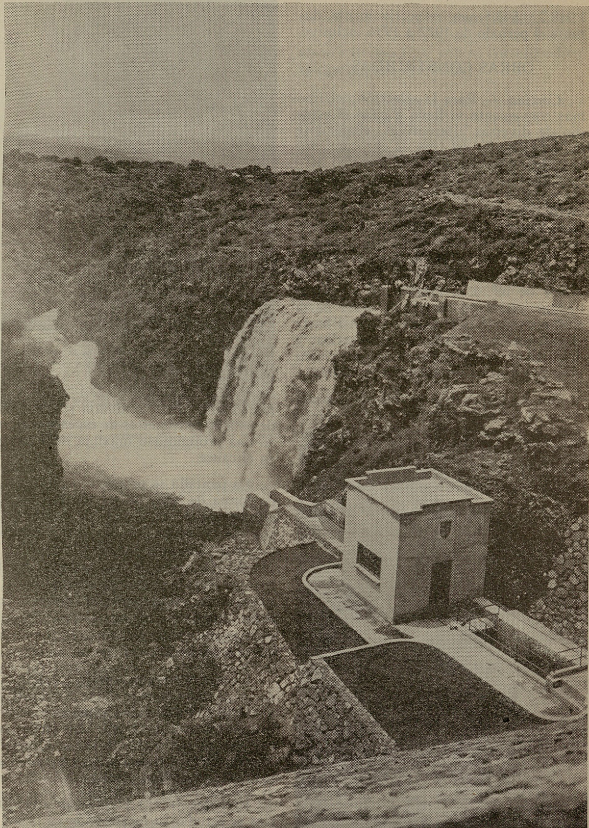
Foto N° 5.—Vista en detalle de la casa de válvulas y dispositivo a la salida de la obra de toma. Nótese al fondo la descarga del vertedor de excedencias.
