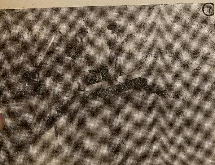
Nº 7.—Haciendo un muestreo de agua en el pozo-Sifón. Puede verse la Bomba auxiliar.
