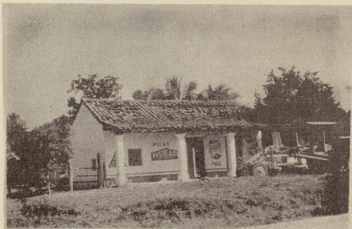
Fig. 28.- Hundimiento de tejas y rotura cerca de la base, de las columnas de una casa de campo en las cercanías de Minatitlán. Construcción antigua.
