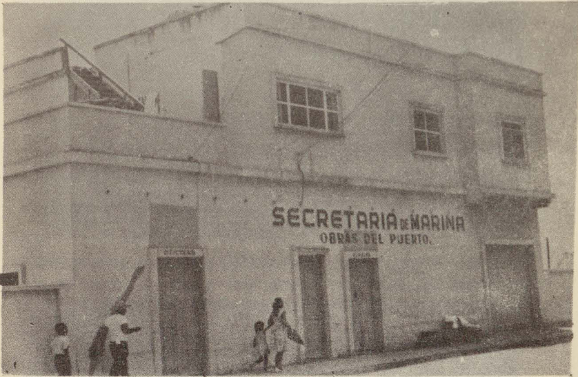
Fig. 2.- Edificio de la Secretaría de Marina en Alvarado, a 161 Km del epicentro. Construido sobre arena. No se notó ningún daño.
