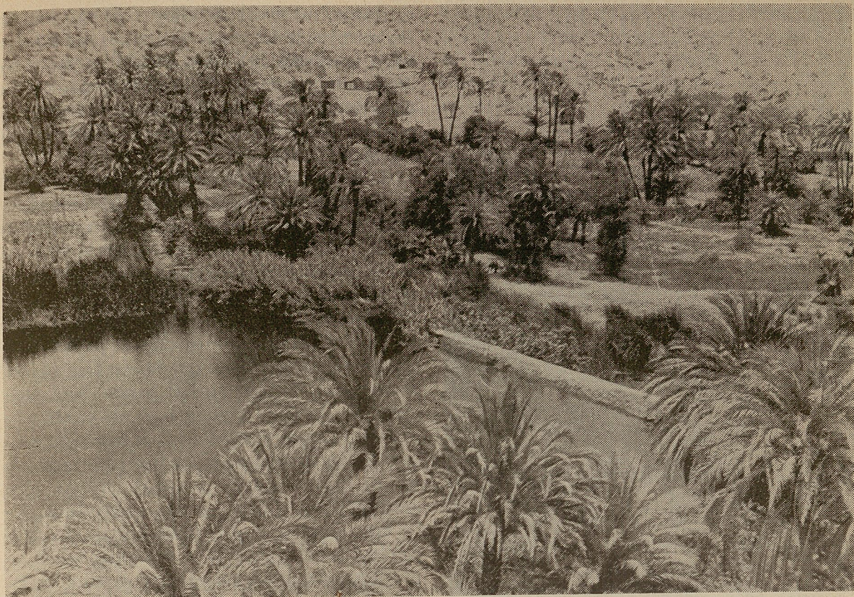
El agua del manantial represada por una pequeña presa de tierra. Mulegá, B. C.
