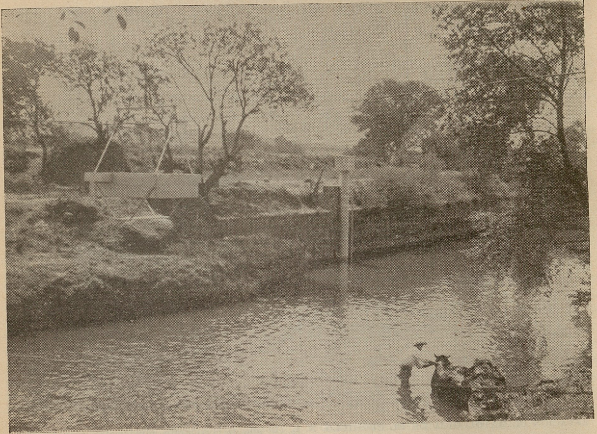
Estación Hidrométrica de El Carmen, Río Atoyac, Pue. (Al fondo la caseta del limnógrafo, construida de tubería de lámina corrugada.) Foto Núm. 2.
